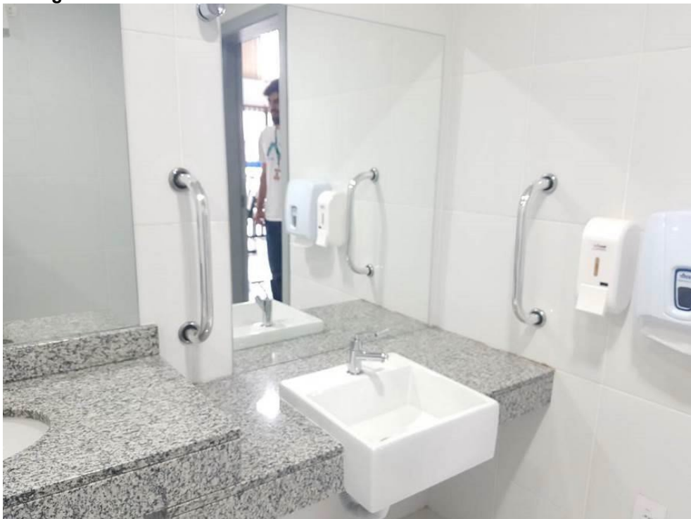
Imagem 37 – Lavatório acessível executado no Fórum Eleitoral de Araucária
